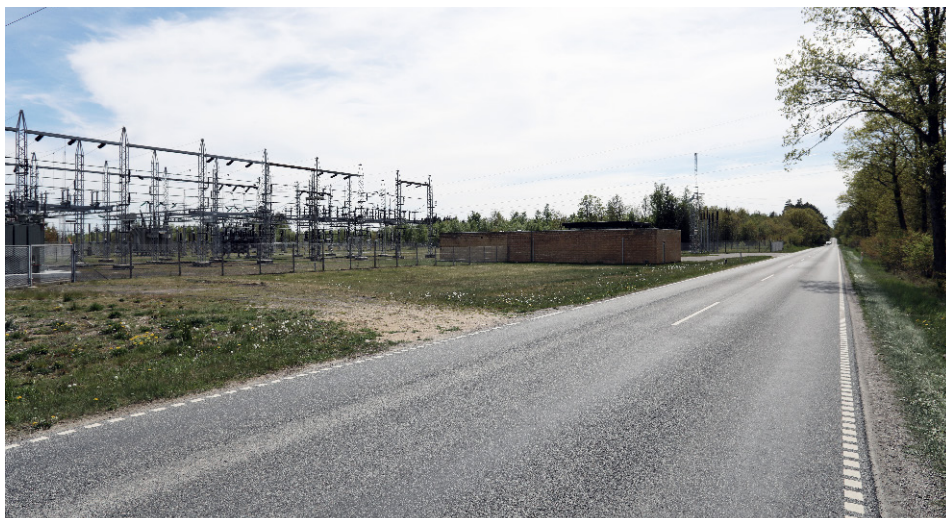
Udsigt fra Thorsagervej i sydlig retning nær den eksisterende transformerstation der ligger midt for lokalplanområdet.
