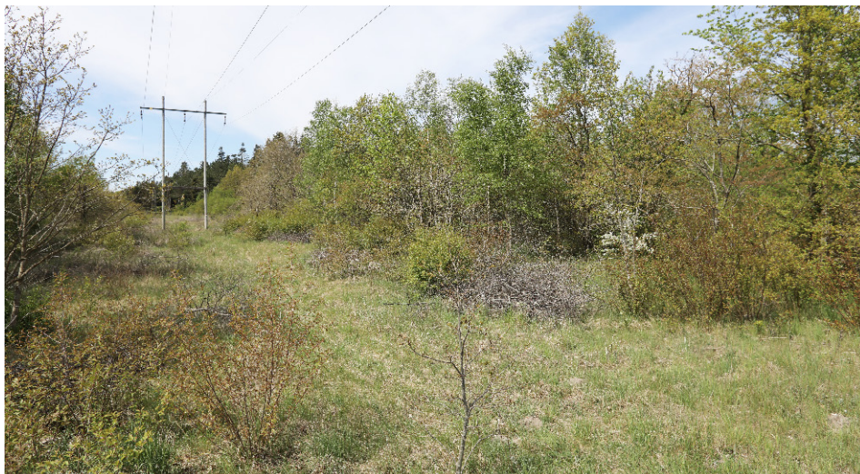
Udsigt fra Thorsagervej i vestlig retning imod et af de højspændingstrace der løber fra Mesballe transformerstation.
